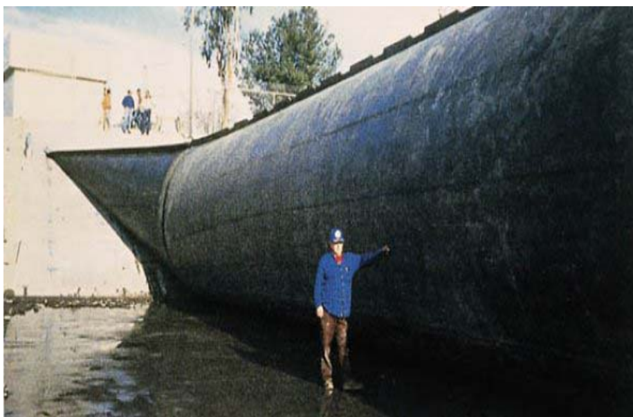
نمای سد لاستیکی قبل و بعد از هوا دهی
