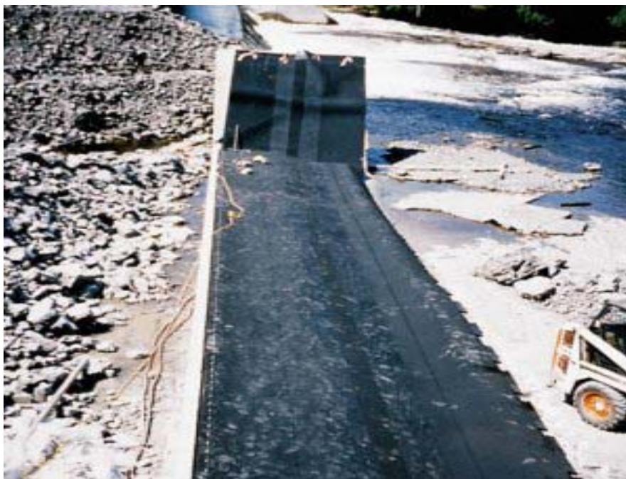
نمای سد لاستیکی قبل و بعد از هوا دهی
